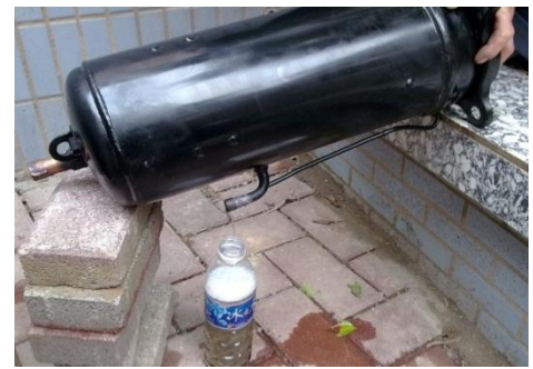
Figura 6-2.8: Drenaje de aceite de un compresor
